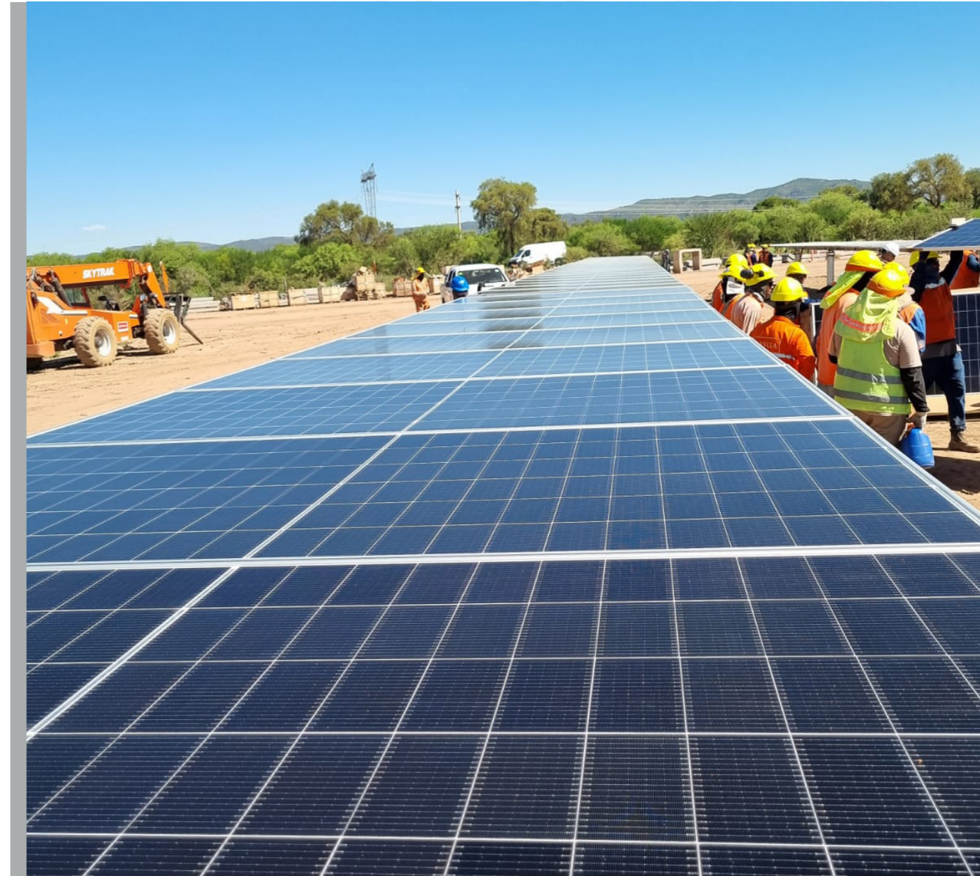
construcción parque solar La Salvación, San Luis
