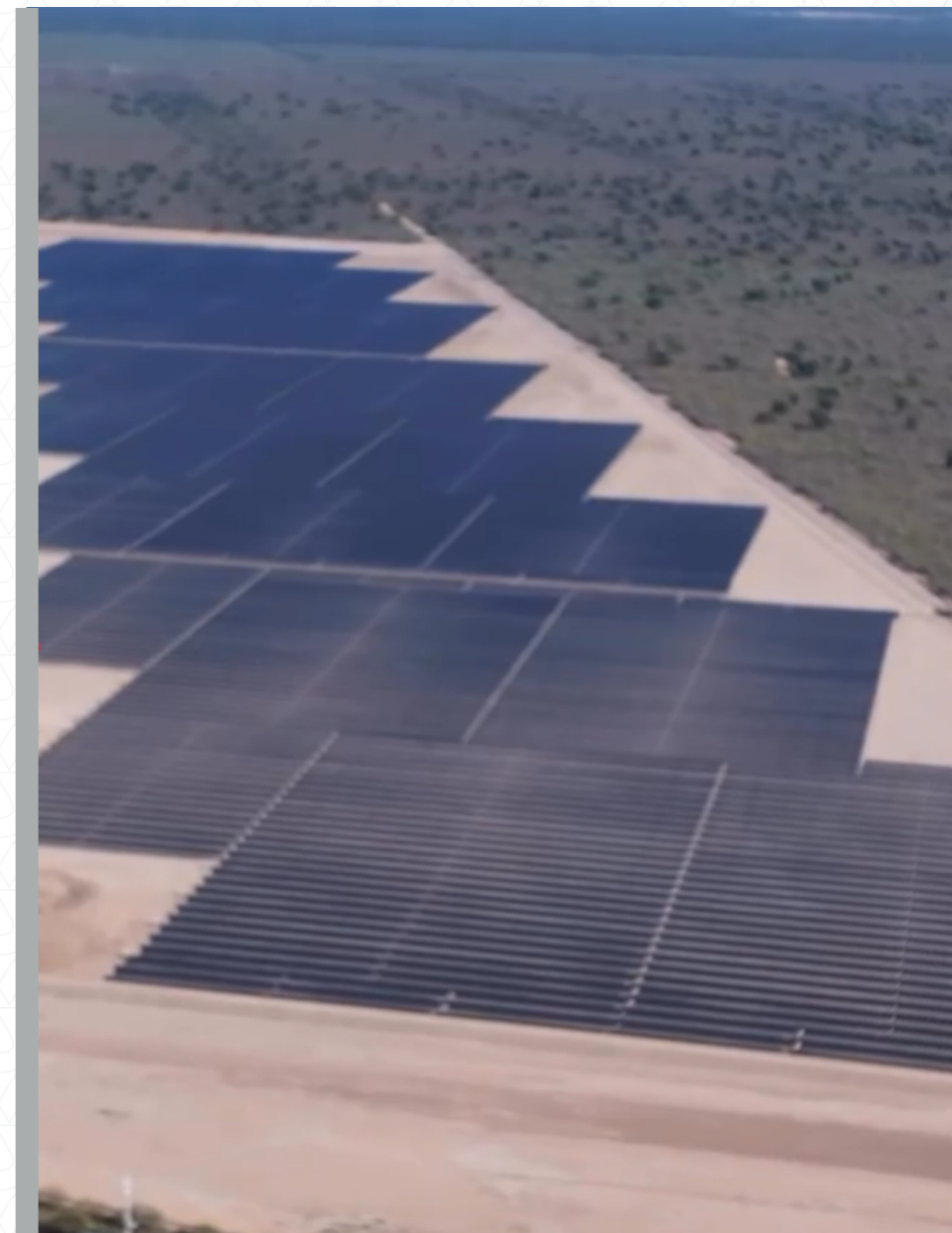
Construcción Parque solar La Salvación
