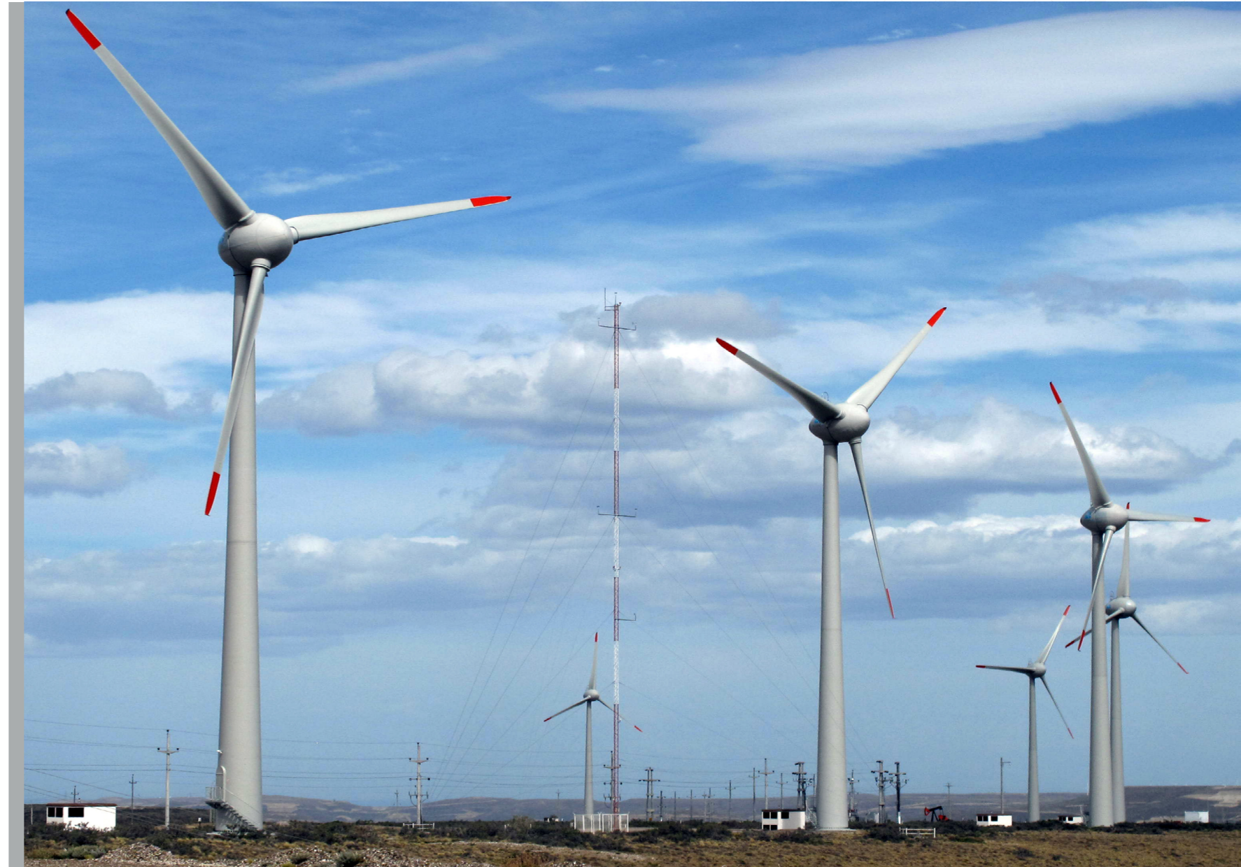
Parque eólico, PED I, Chubut
